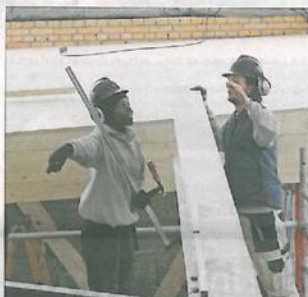
Den usædvanligt og kompliceret ombygning kræver en høj grad af koordinering og kommunikation.
